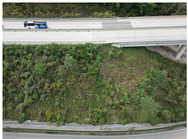
상부 성토부 전경
